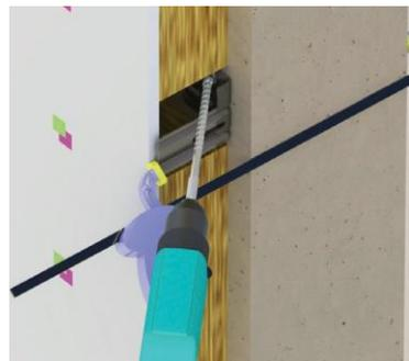
**6** Visser en appui optimal la tête de vis grâce au bossage oblique.
