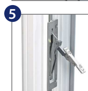
Crémone de semi-fixe (verrouillage par renvoi d'angle)
