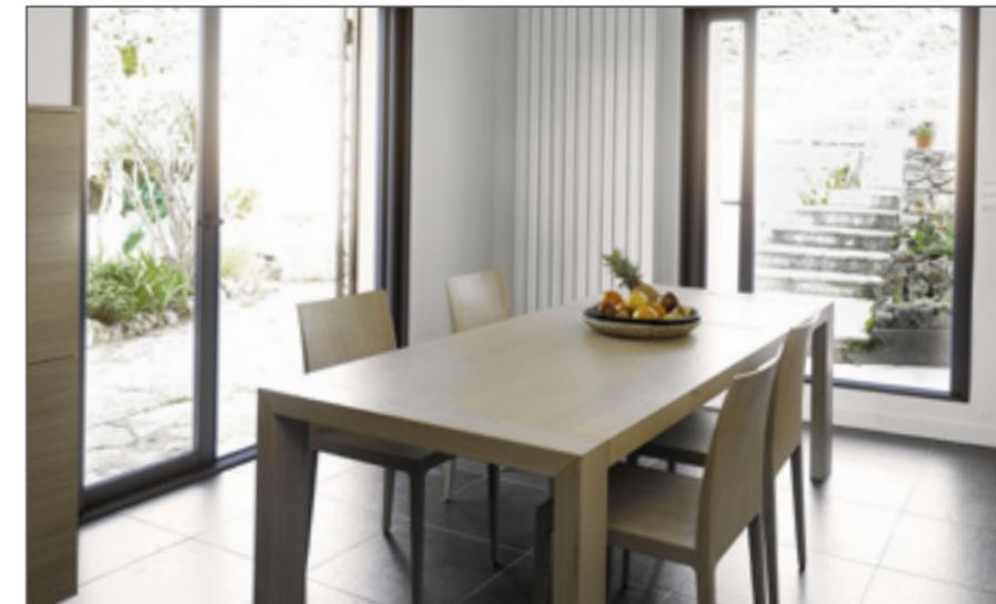
Le coulissant galandage permet de dissimuler le(s) vantail(aux) dans l'épaisseur du mur pour avoir une totale ouverture sur l'extérieur.
